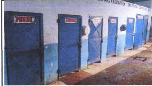
FOTO 2: Mantenimiento a estructura (lijado, cambio de tubo , cepillado, sujeciones, aplicación de pintura) a puertas servicios sanitarios
