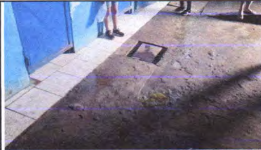
FOTO 1: Sustrucción de piso de torta de concreto Por piso Cerámico (antideslizante)
