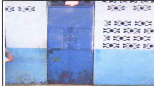
FOTO 4: Mantenimiento a estructura (lijado, cambio de tubo , cepillado, sujeciones, aplicación de pintura) PUERTA EN COCINA
