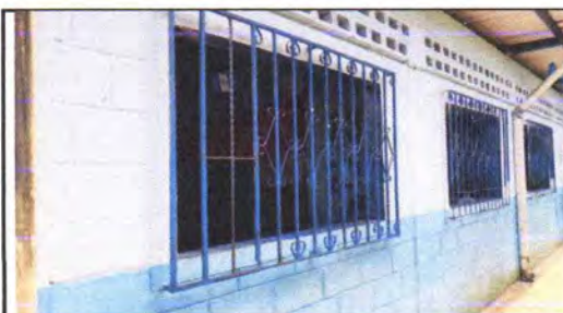
FOTO 12: Mantenimiento a balcones de metal Aula no 1,2,3 y 4
