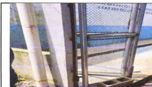
FOTO 18: Mantenimiento a portones de metal EN PATIO
