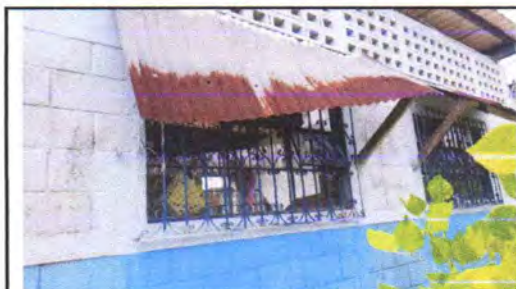
FOTO 9: Sustrucción de lámina, por lámina troquelada aluzinc calibre 28 Y Sustrucción de estructura de soporte de madera, por metal EN AULAS
