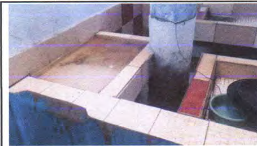
FOTO 3: Sustrucción de tubería PVC línea principal aguas negras EN BAÑOS
