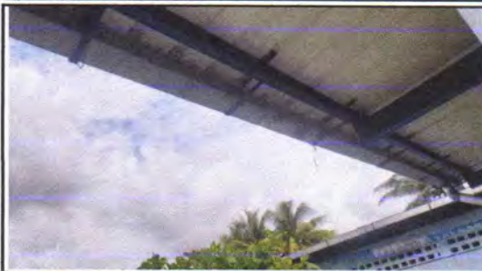
FOTO 13: Sustitución de canal de metal aula no.7 Y Sustitución de bajada de agua pluvial de metal por tubo PVC 3"
